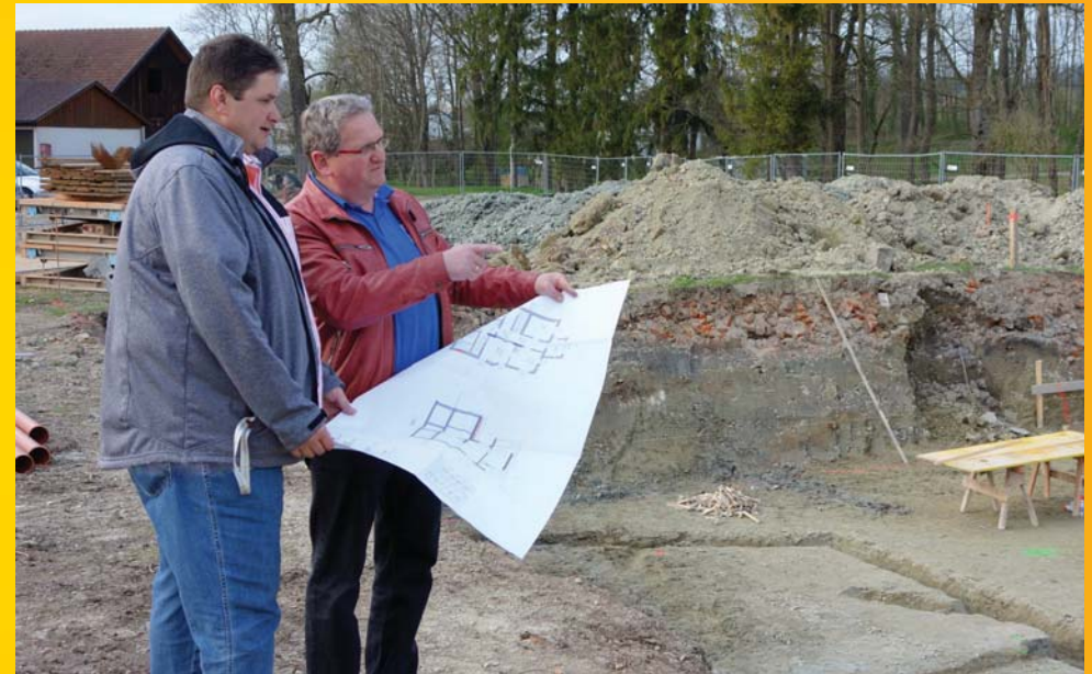
Baustellenbegehung des neuen Wohnblocks „Am Schlossgrund“ durch Bürgermeisterkandidat Franz Schabetsberger und Fraktionsobmann Franz Arthofer
