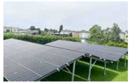
Die neu errichtet 30 kWp Photovoltaikanlage zur Abdeckung des Grundverbrauches im Freibad Riedau.
