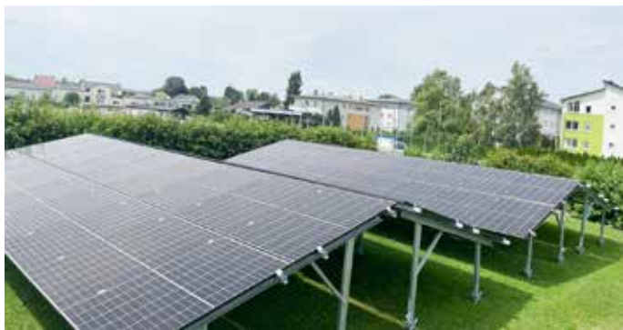
Die Photovoltaikanlage im Freibad wurde bereits montiert und in Betrieb genommen, um dadurch den Abgang zu reduzieren.
